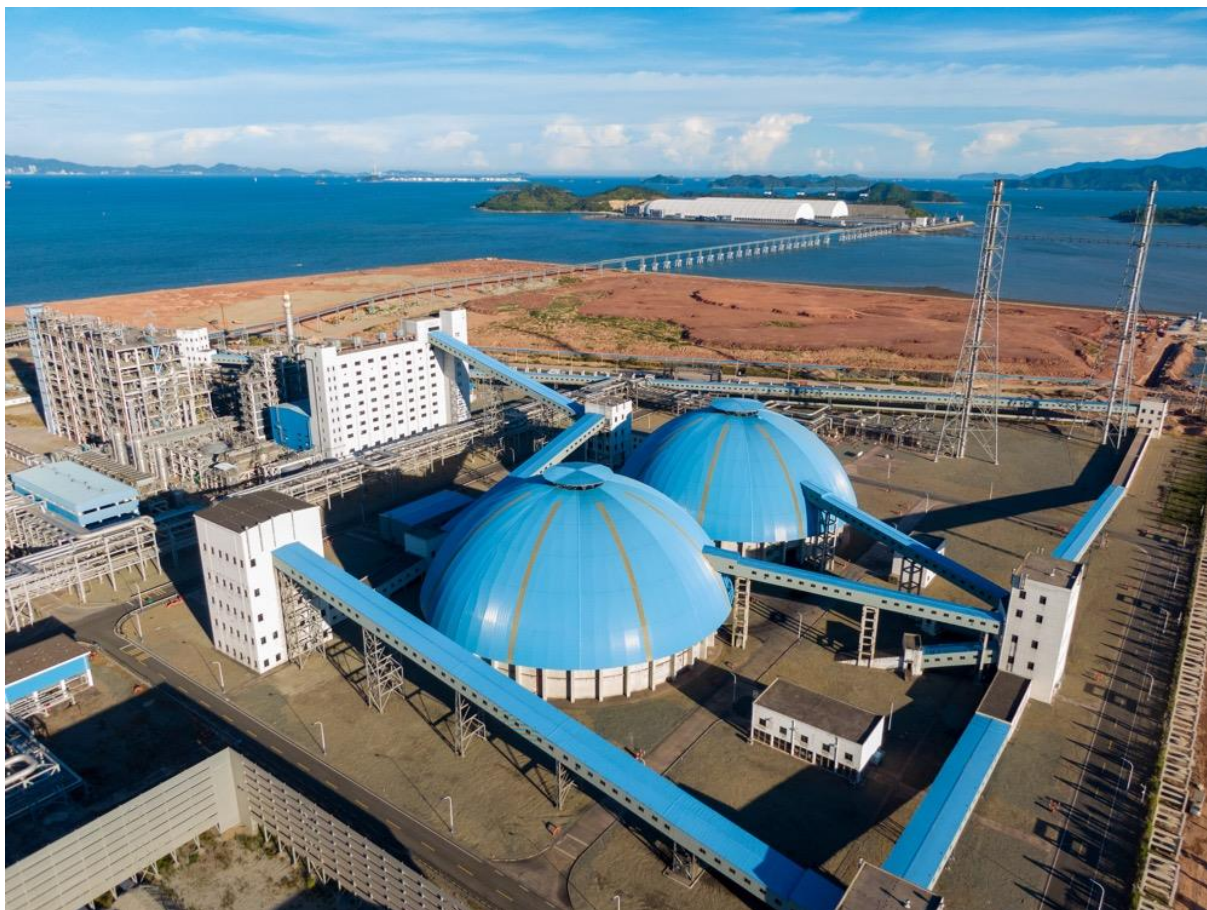
图为我国首套 E-Gas 煤制氢联合装置
