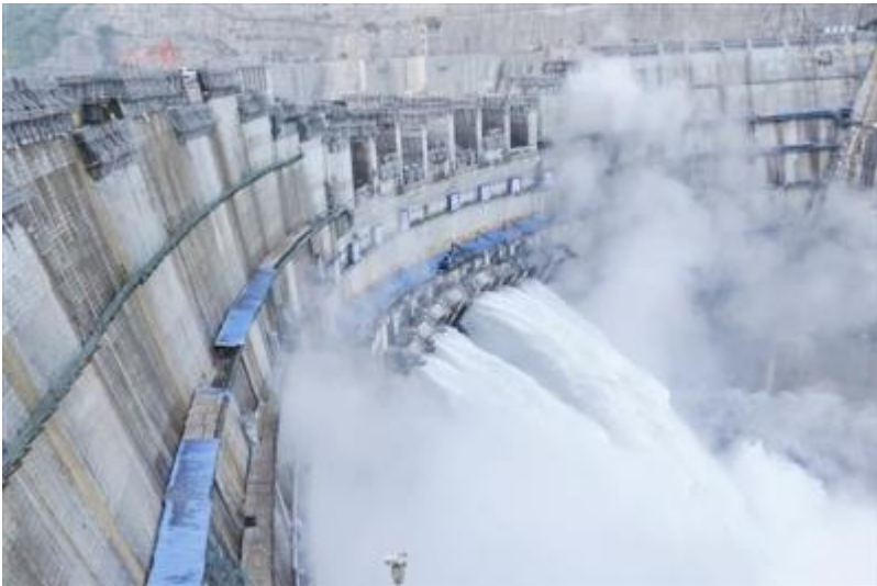
东方电机制造的溪洛渡 770 兆瓦 18 号机完成 72 小时试运行。
